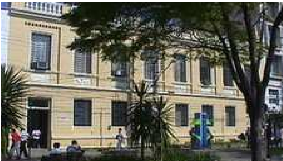
Figura 2 – Sede da Diretoria de Ensino da Região de Guaratinguetá - SP
