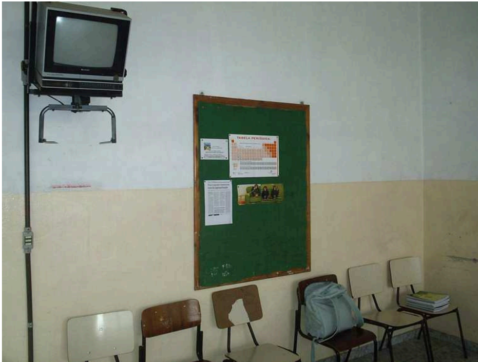
Figura 10. Painel de feltro/madeira como elemento de controle de reverberação. (Fonte: O autor)
