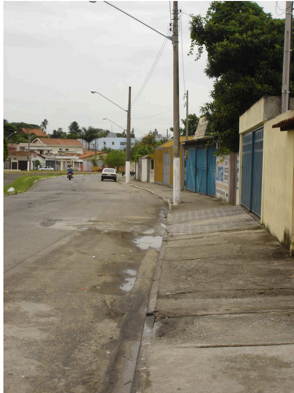
Figura 4 – Avenida Juca Esteves: insuficiência de lixeiras instaladas
