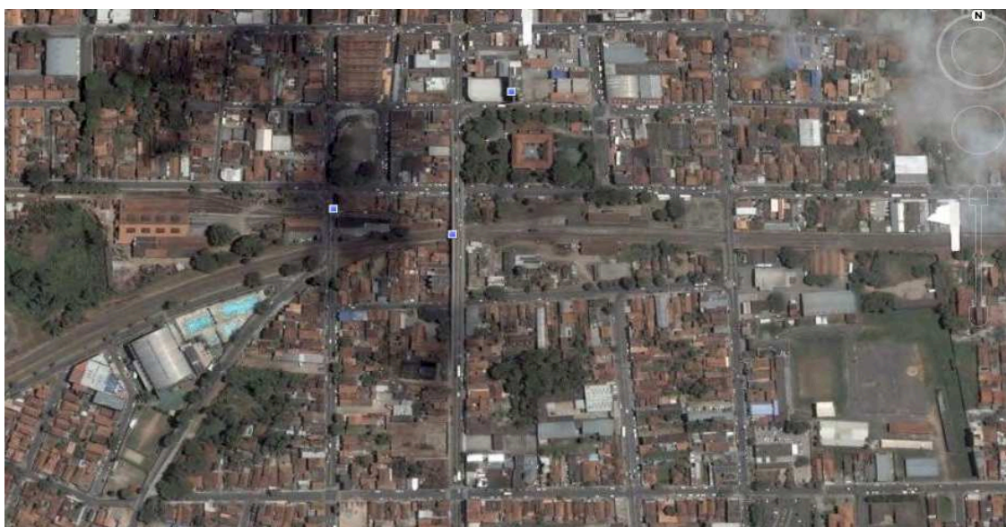
FIGURA 06A: Imagem Satélite da região central de Pindamonhangaba indicando cobertura asfáltica de 100%
