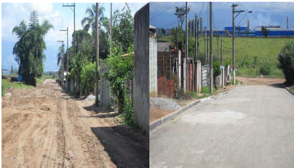
FIGURAS 08B e 08C: Imagem in loco do setor Feital, indicando o asfaltamento parcial . FONTE: Própria - 2008
