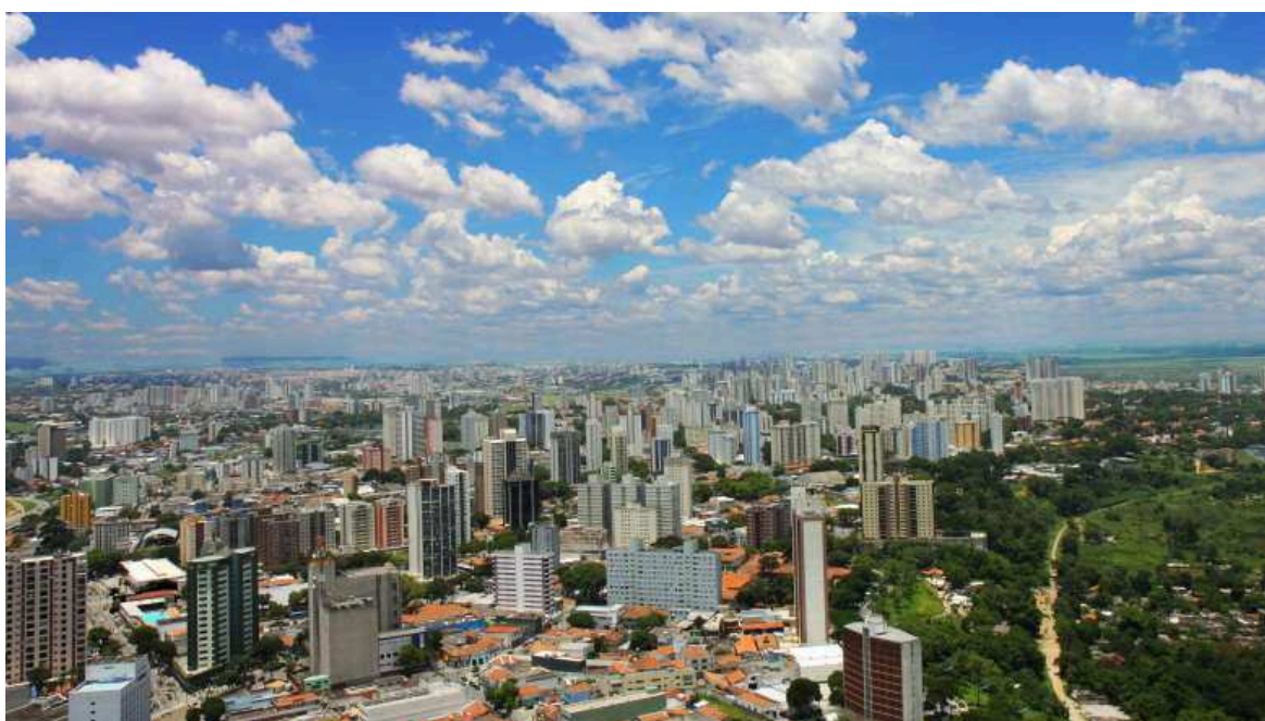
Figura 20- Vista  rea de SJC 2012 Fonte: foto Ademir Brito - pmsjc.sp.gov.br
