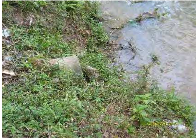
Figura 33: Esgoto lançado no Ribeirão. Fonte: Foto do autor, 2009.
