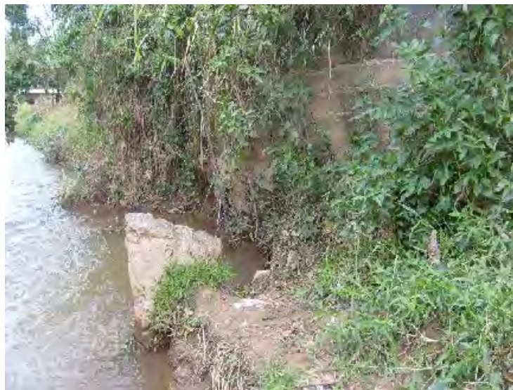
Figura 32: Muro no leito do Ribeirão.
