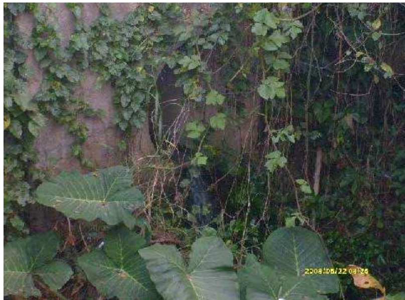
Figura 40: Esgoto lançado no Ribeirão. Fonte: Foto do autor, 2009.
