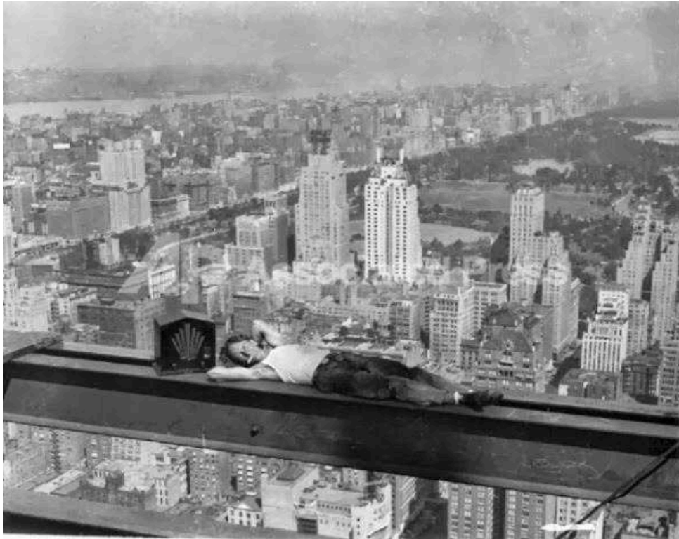
Figura 3 Trabalhador descansando em uma das vigas na construção do Rockefeller Center Fonte: Cavalcante, 2015
