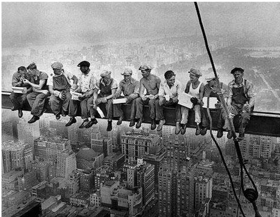
Figura 1 operários sentados em uma viga na construção do edifício Rockefeller Center em Nova York, 1932 Fonte: Rabelo, 2008
