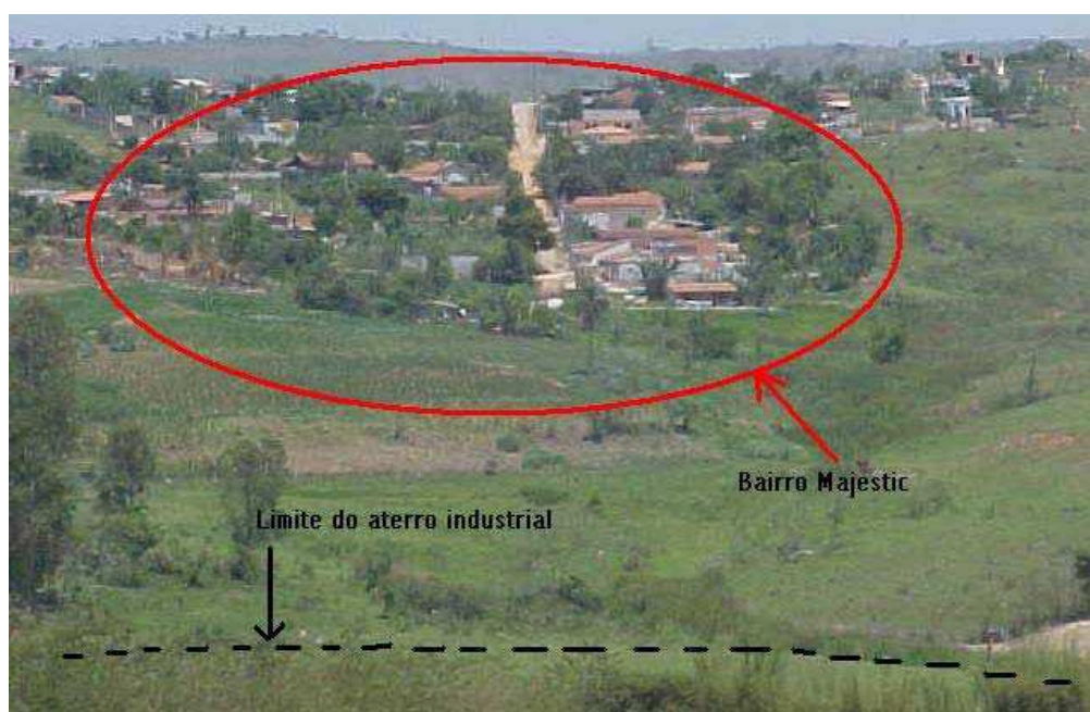
FIGURA 12 – Bairro Majestic – processo de autoconstrução e proximidade ao limite do aterro industrial
