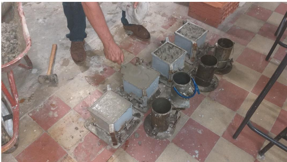
Figura 10 – Nivelamento dos corpos de prova cúbicos
