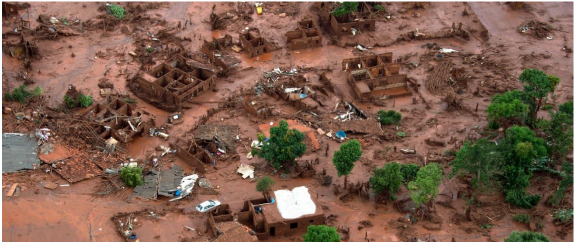
Figura 9. Vista aérea do distrito de Bento Gonçalves após o acidente.
