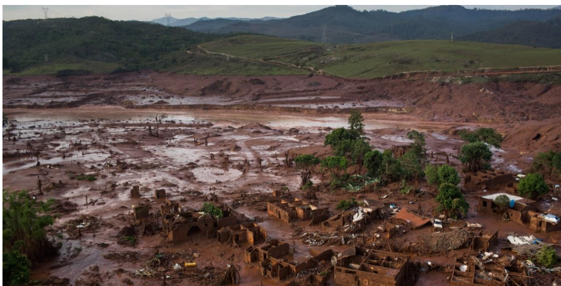
Figura 8. Vista aérea do distrito de Bento Gonçalves após o acidente.
