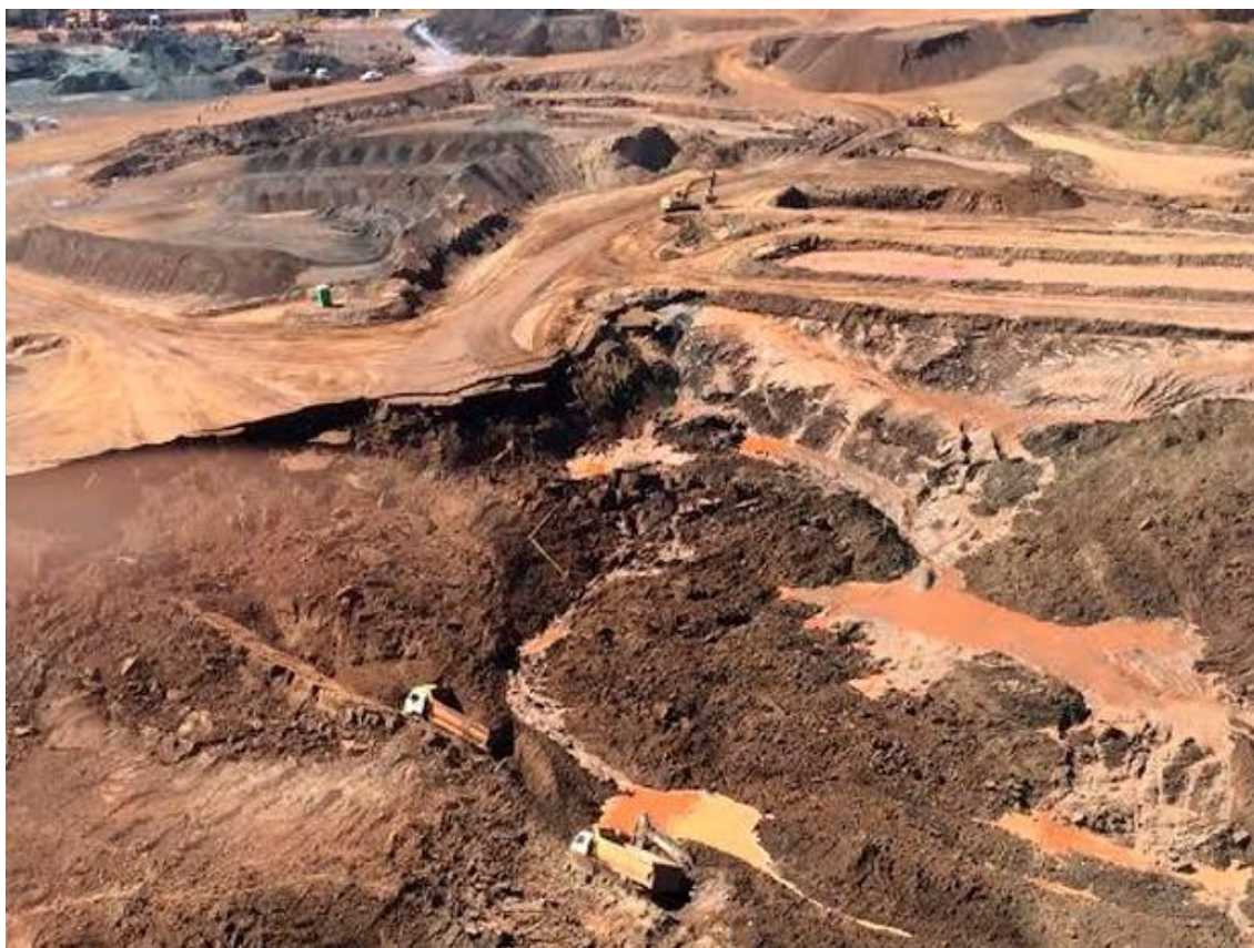
Figura 6. Foto aérea mostrando a lama após o rompimento da barragem de Herculano que soterra trabalhadores e veículos.
