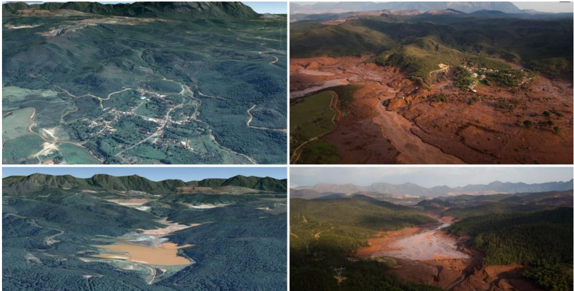
Figura 12. Vista aérea mostrando o antes e o depois da barragem.
