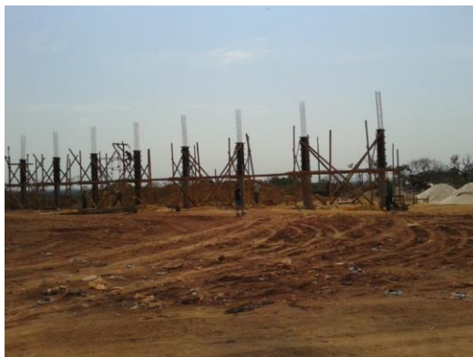
Imagem 23- construção da área de transbordo
