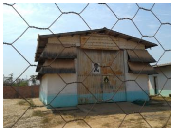
Imagem 26- Barracão de armazenamento das embalagens tóxicas.
