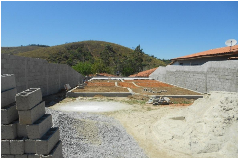
Figura 12: Imagem de construção, bairro Registro, Taubaté-SP
