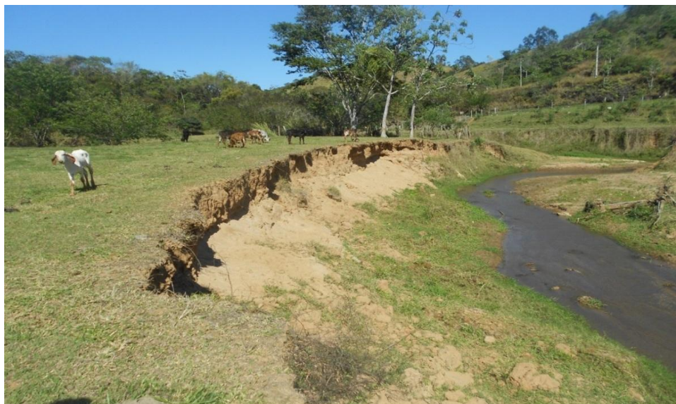
Figura 10: Imagem de erosão às margens do rio Una
