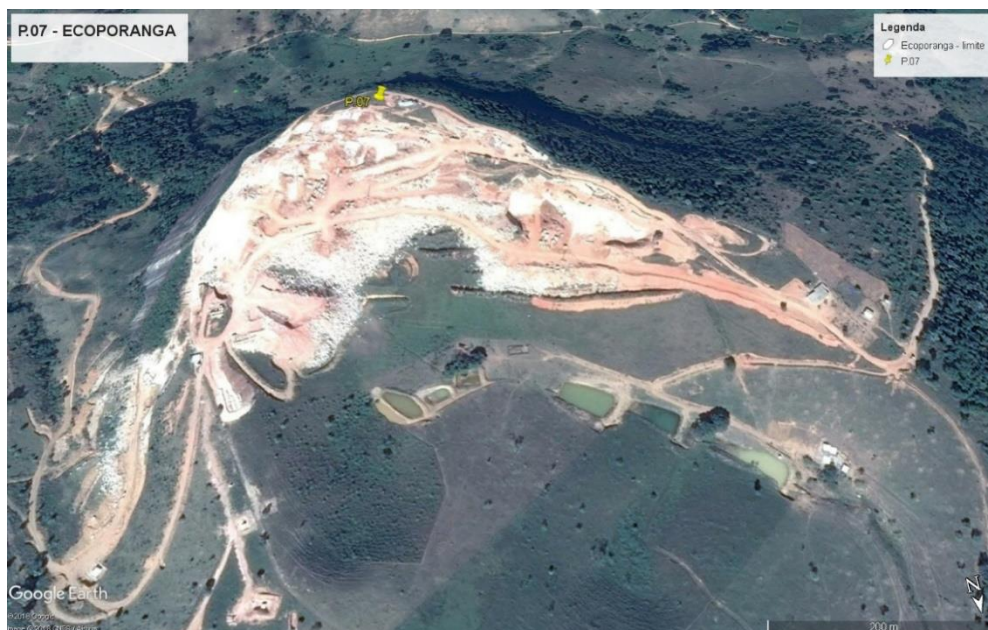
Figura 21 - Área de Lavra com várias áreas de bota-fora e estradas mal projetadas, propício à ocorrência de erosões e assoreamento de lagoas.
