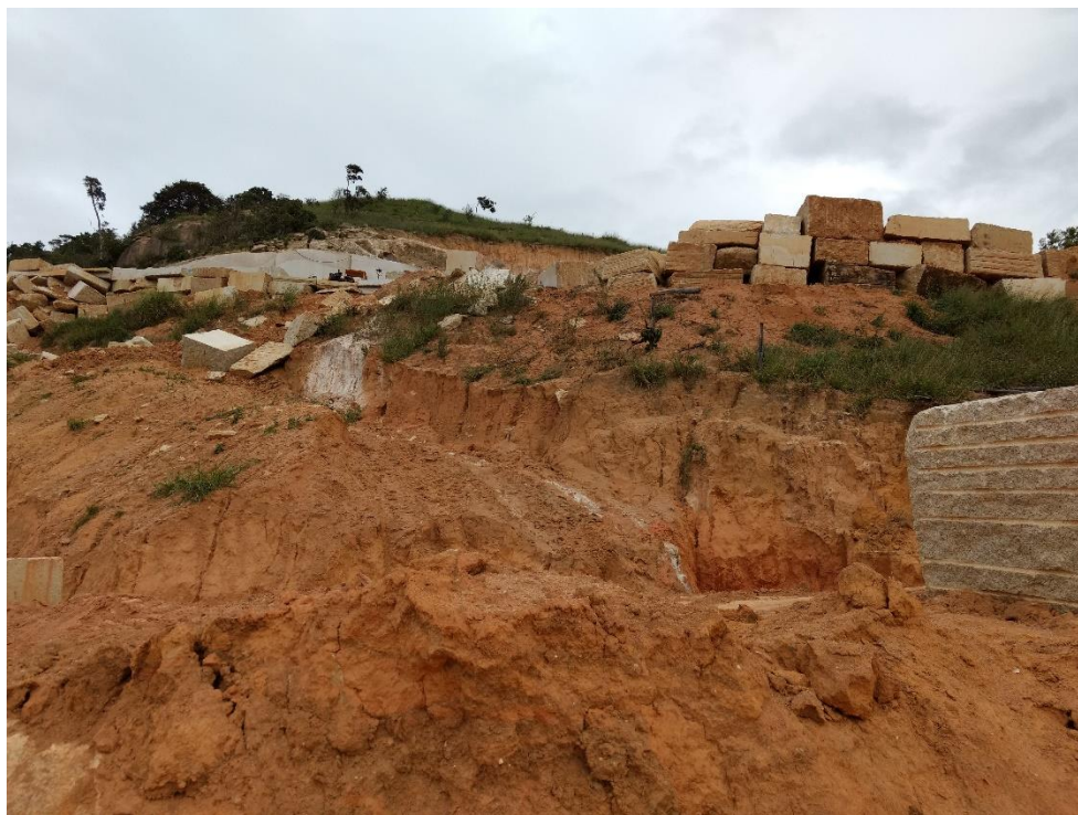
Figura 18 - Impacto Ambiental causado pela movimentação do solo na lavra e processo erosivo – influência pela má disposição dos resíduos no solo.
