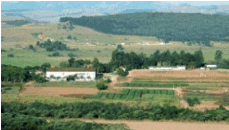
Figura2. Vista geral do Departamento de Ciências Agrárias da UNITAU.
