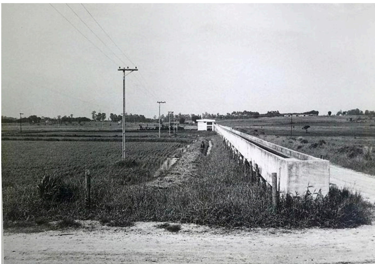
Figura 6: Canal de Irrigação polder Pinda IV
