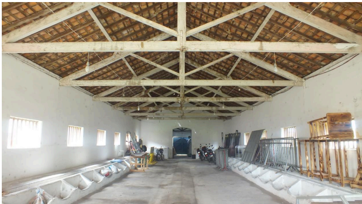
Figura 38: Interior das construções
