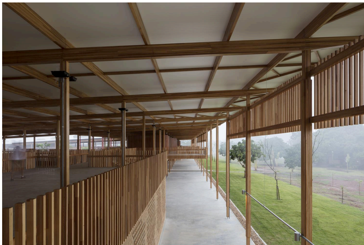
Figura 15: Disposições dos beirais da edificação
