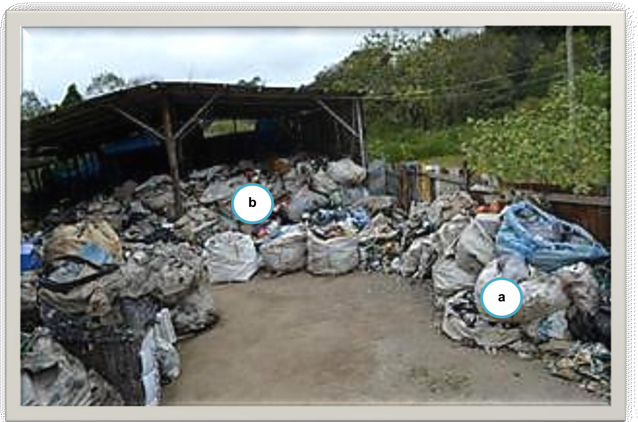
Figura 23 Estrada de acesso ao bairro Rio Claro – galpão de acondicionamento de resíduos – estrutura precária, 2012: (a) Latas de bebidas em geral; (b) Recipientes de vidros em geral
