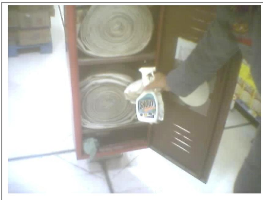
Figura 14 Materiais inadequados no interior de abrigo de mangueiras
