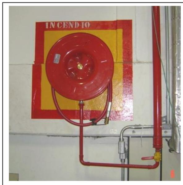
Figura 25 Mangotinho para combate a incêndio, DN 25, modelo 1SW (manual), marca Kidde.
