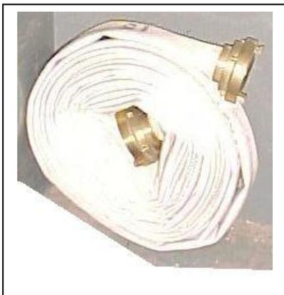
Figura 11 Mangueira com acondicionamento em espiral
