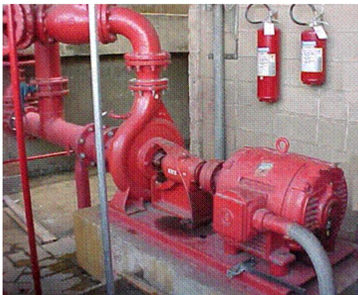
Figura 5 Instalação de uma bomba centrífuga (eixo horizontal)
