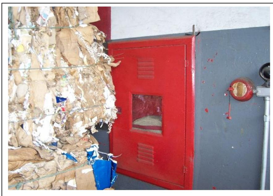
Figura 30 Falta de sinalização e estocagem em frente ao hidrante.
