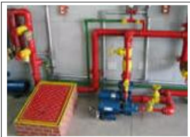
Figura 27 Tubulação aparente do sistema de hidrantes
