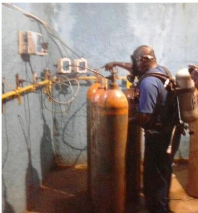
Figura 2 Operador de tratamento de água trocando o cilindro de gás cloro.
