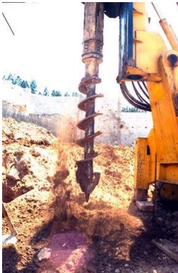
Figura 3 - Detalhe do equipamento de escavação. Fonte: http://www.basestrauss.com.br/escavada.html
