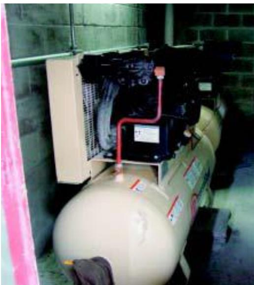
**Figura 03-** compressor isolado e enclausurado
