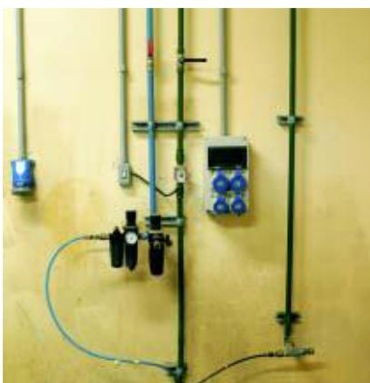
**Figura 06-** Instalações elétricas, de linhas de ar pressurizadas e de água
