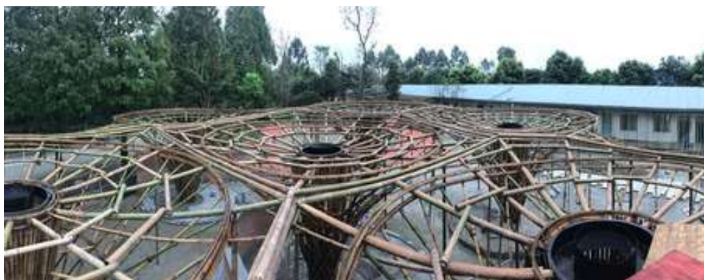
Figura 33. Execução do projeto estrutural
