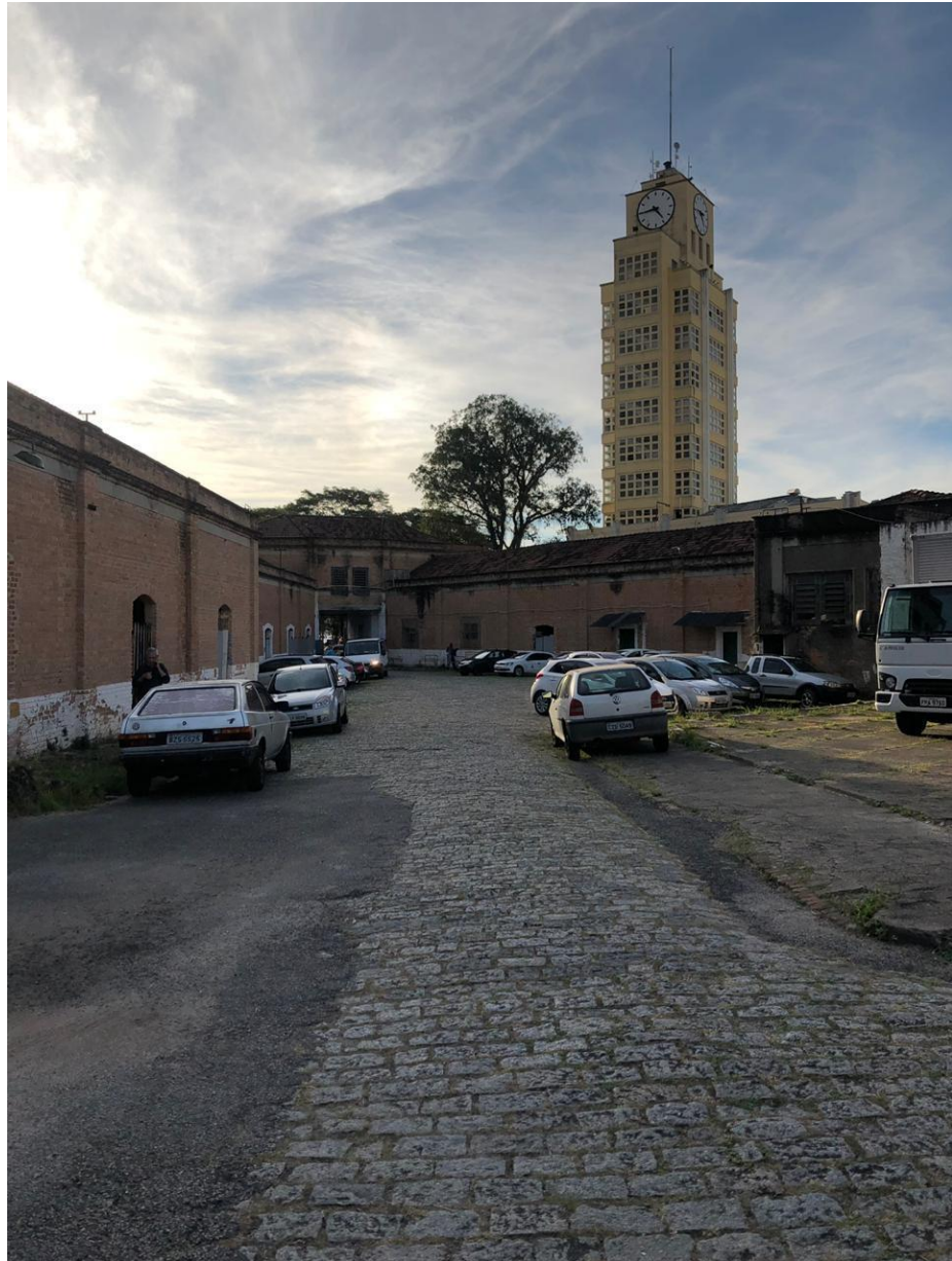
Figura 31 - Situação atual área central do terreno
