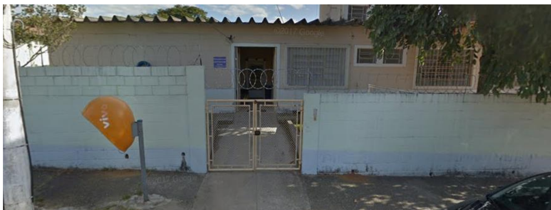
Fonte: (STREET VIEW, 2020)
