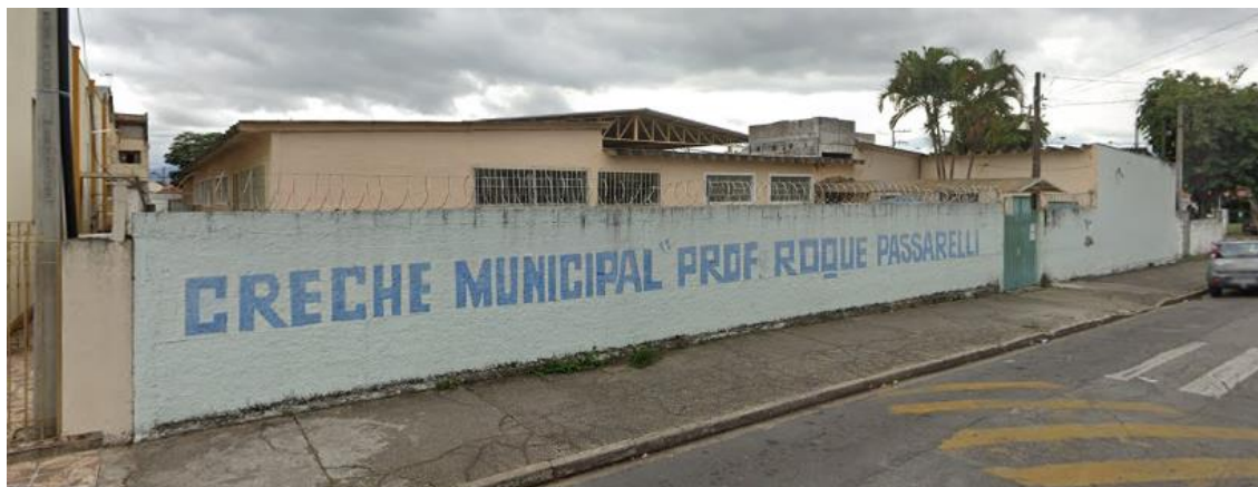
Fonte: (STREET VIEW, 2020)
