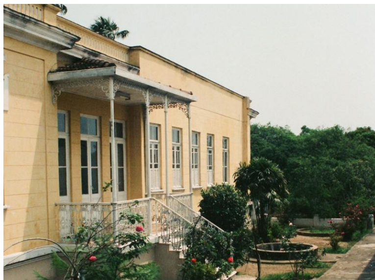
Figura 22. Fachada lateral Villa Santo Aleixo.
