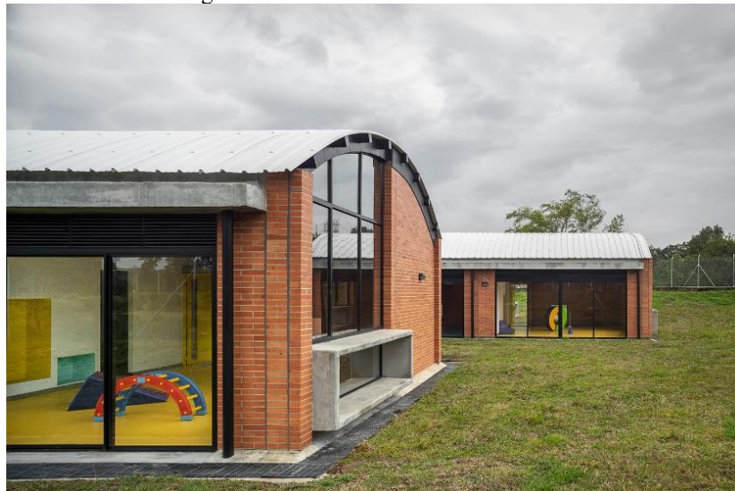
Figura 9. Fachadas mostrando aberturas.
