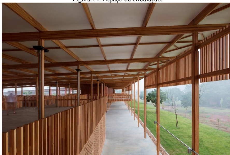
Figura 14. Espaço de circulação.
