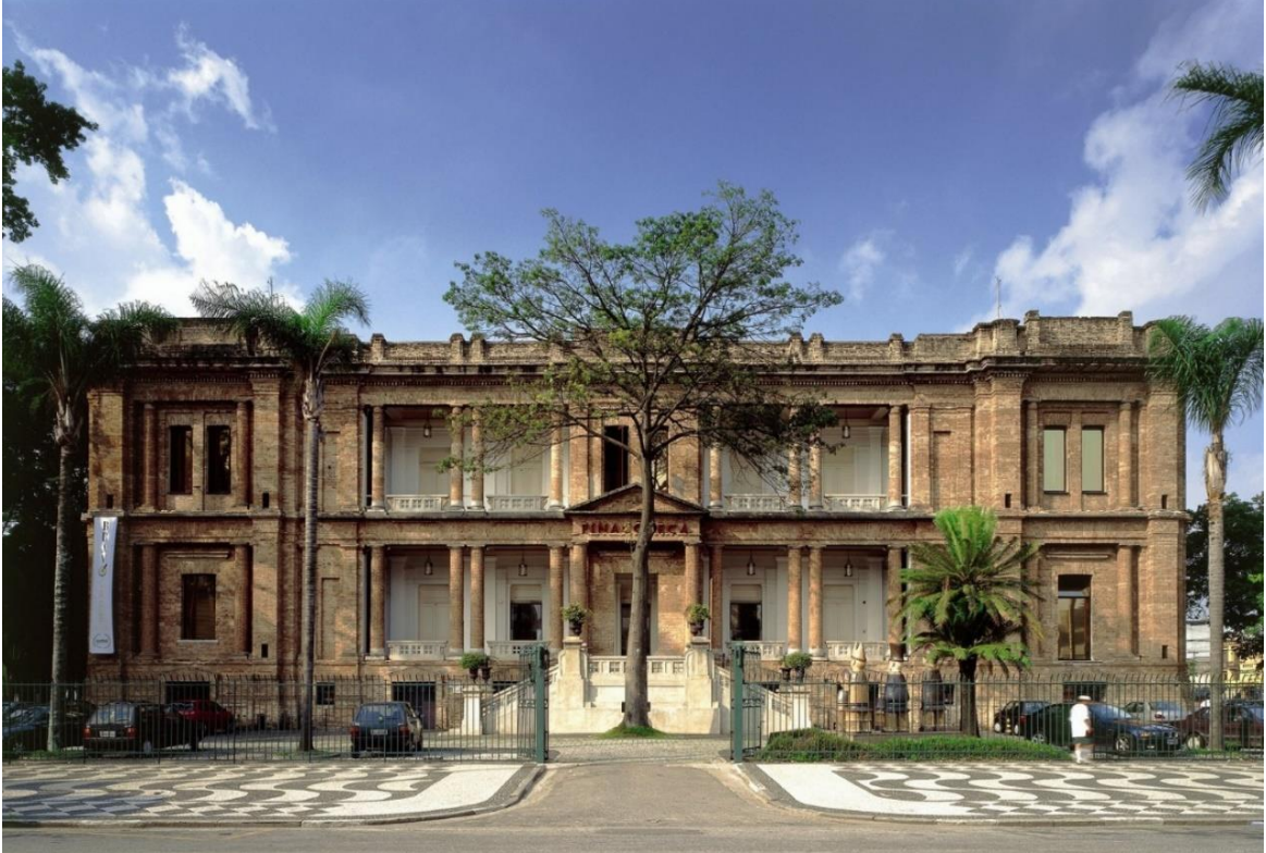
Figura 7 – Fachada da Pinacoteca
