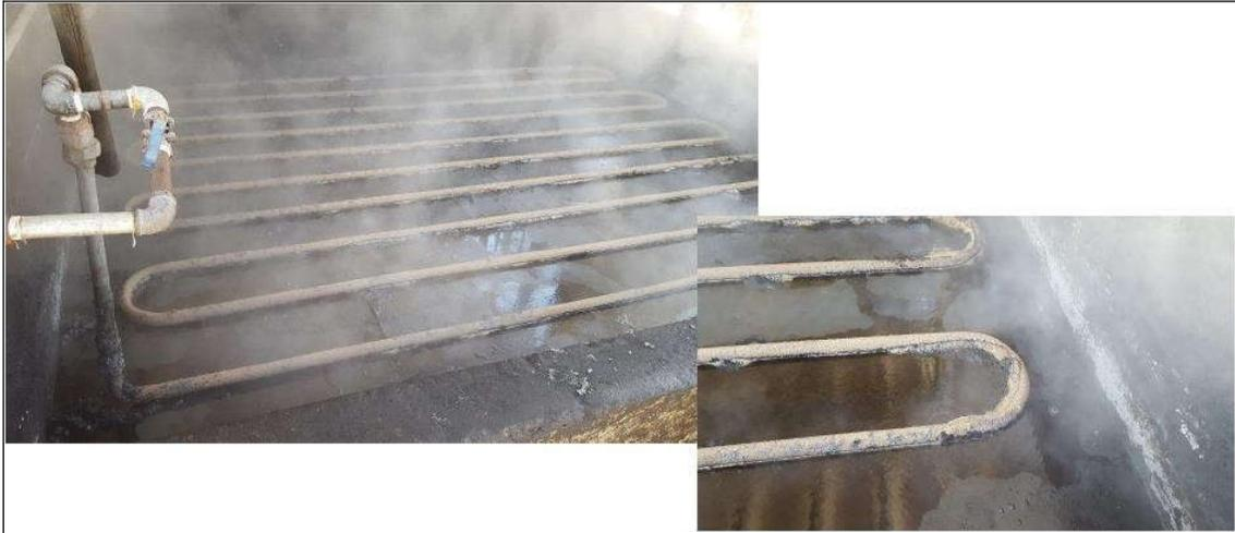
Figura 2 Serpentina de secagem térmica do lodo
