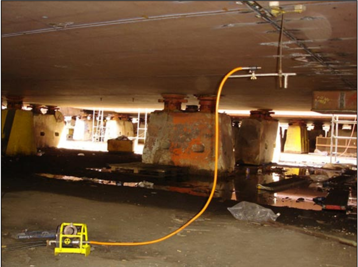
Figura 4 Inspeção com aparelho de gamagrafia
