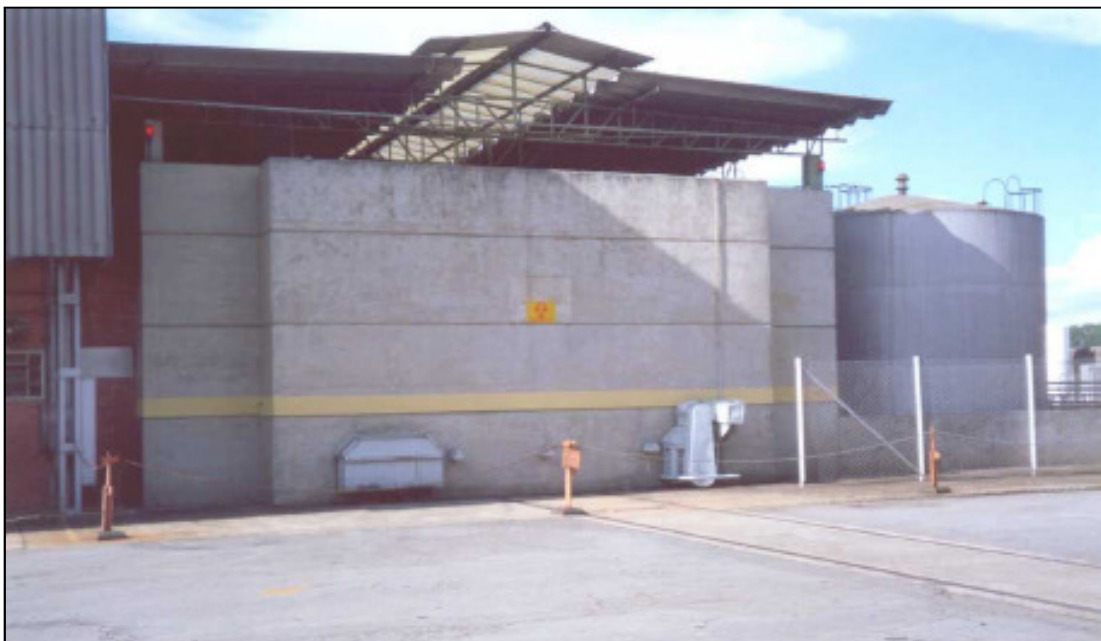
Figura 7 Exemplo de instalação fechada
