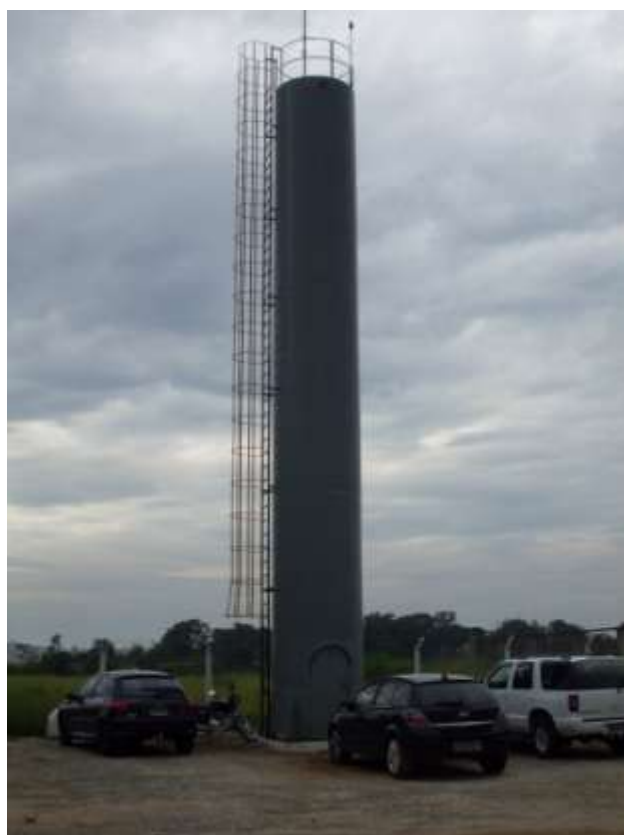
Figura 24 Reservatório Tipo Coluna Fonte: A autora, 2009.
