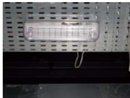
Figura 12 Modelo da Iluminaria de emergência Fonte: A autora, 2009.
