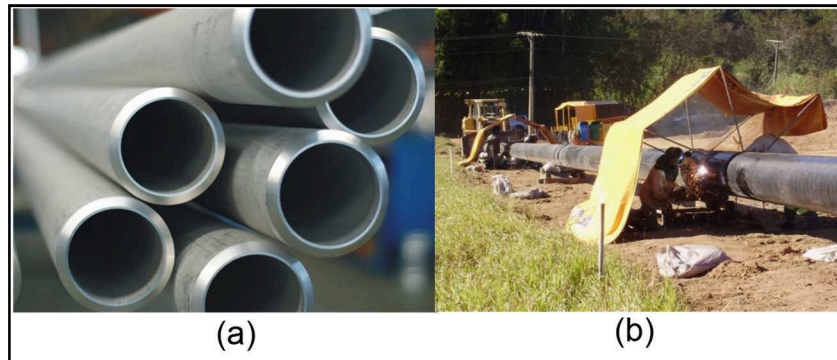
Figura 5. (a) Tubos preparados com biseis usinados (CHILEXPO, 2017). (b) soldagem de topo dos tubos formando uma coluna (PETROBRAS, 2010).
