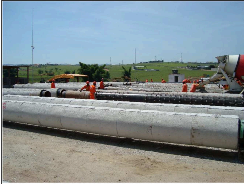
Figura 41. Tubos concretados (PETROBRAS, 2017).
