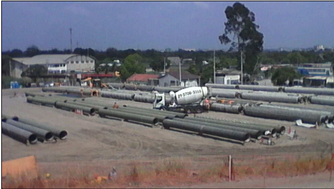
Figura 30. Canteiro de Obras com tubos armazenados (PETROBRAS, 2014).
