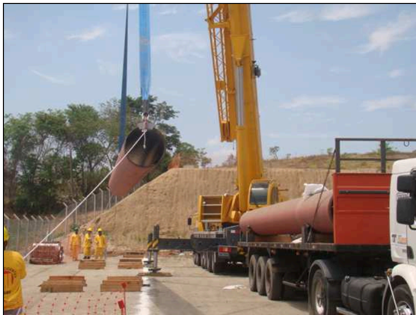
Figura 26. Profissionais trabalhando em área com tubos estocados (PETROBRAS, 2014).
