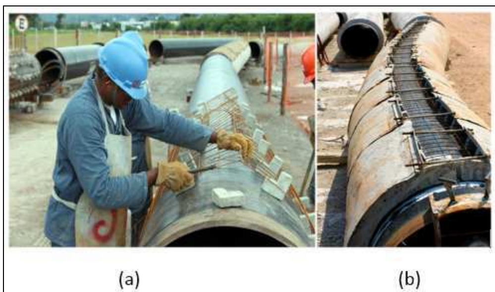
Figura 40. (a) Instalação de armadura de tela nos tubos. (b) Armadura de tela instalada no tubo (PETROBRAS, 2017).
