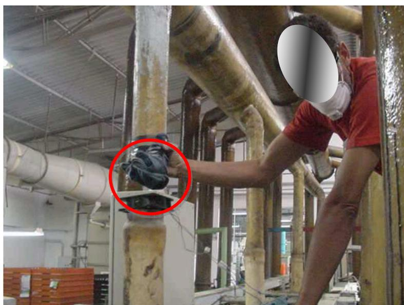
**Figura 39:** Instalação do ventilador pequeno no sistema de exaustão.
