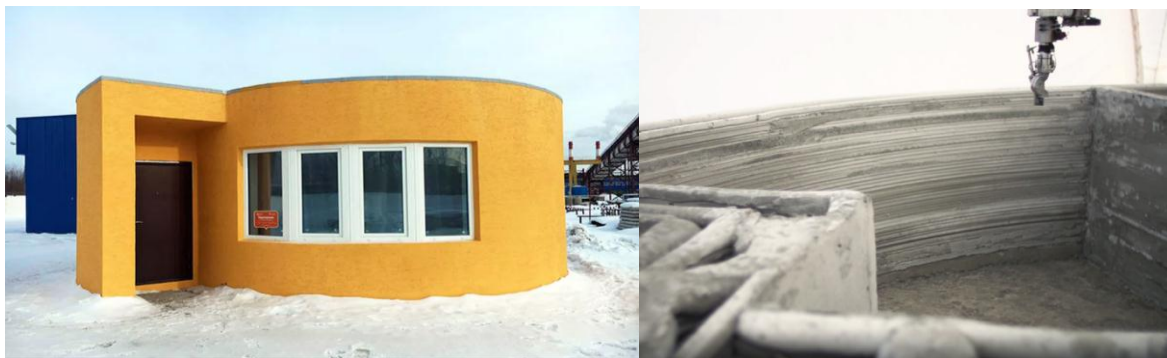
Figura 11: paredes da casa são impressas com concreto em menos de 24 horas
