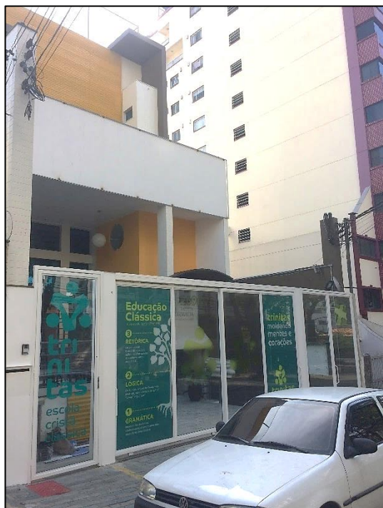
Figura 25: Fachada da Escola Trinitas.
