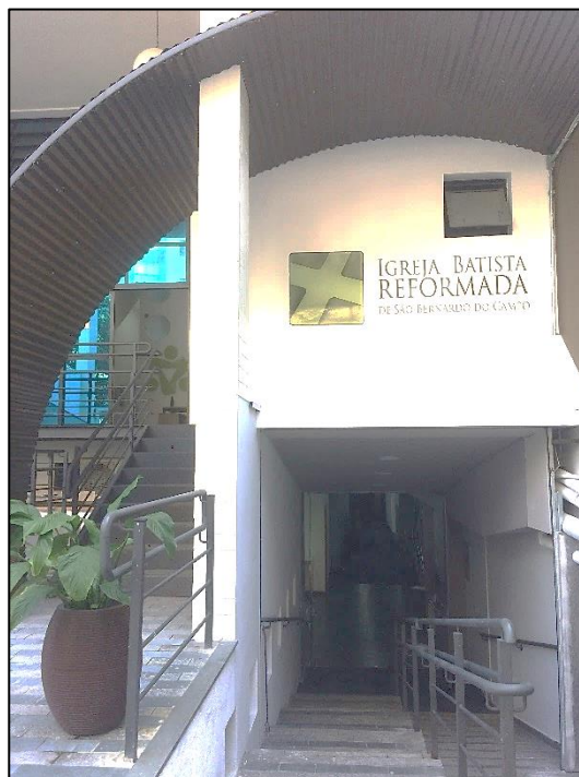
Figura 26: Acesso à Igreja da Escola.
