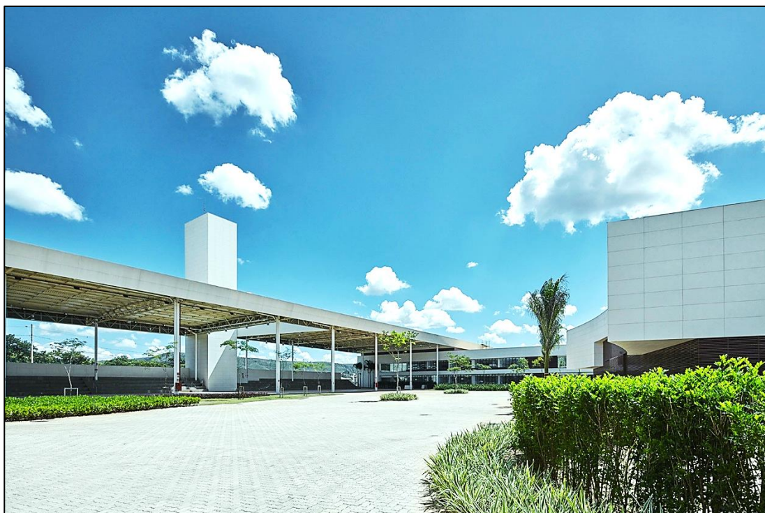
Figura 54: Vista do bloco Central.
