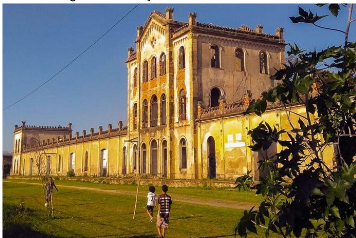
Figura 9 - Estação Ferroviária Atualmente
