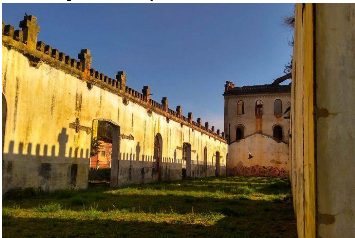
Figura 11 - Estação Ferroviária Atualmente
