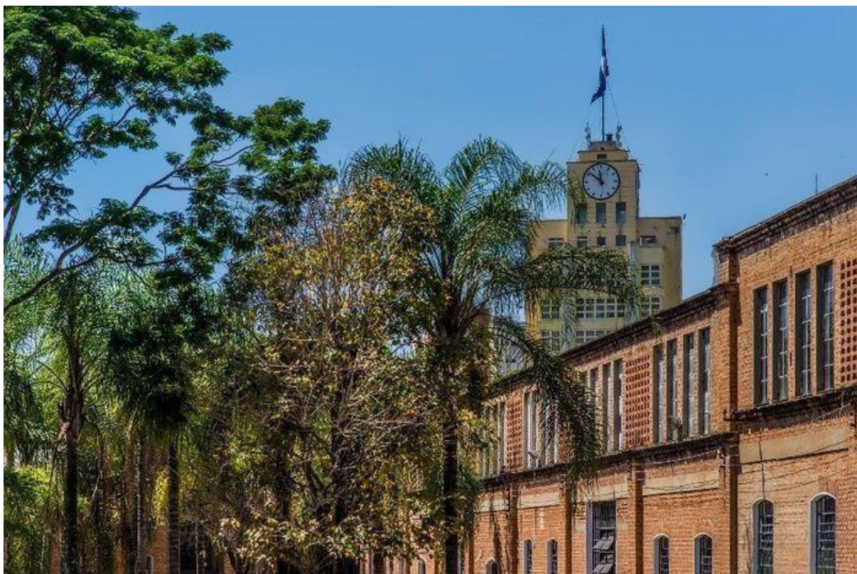
Figura 25 - Vista do Relógio da CTI
