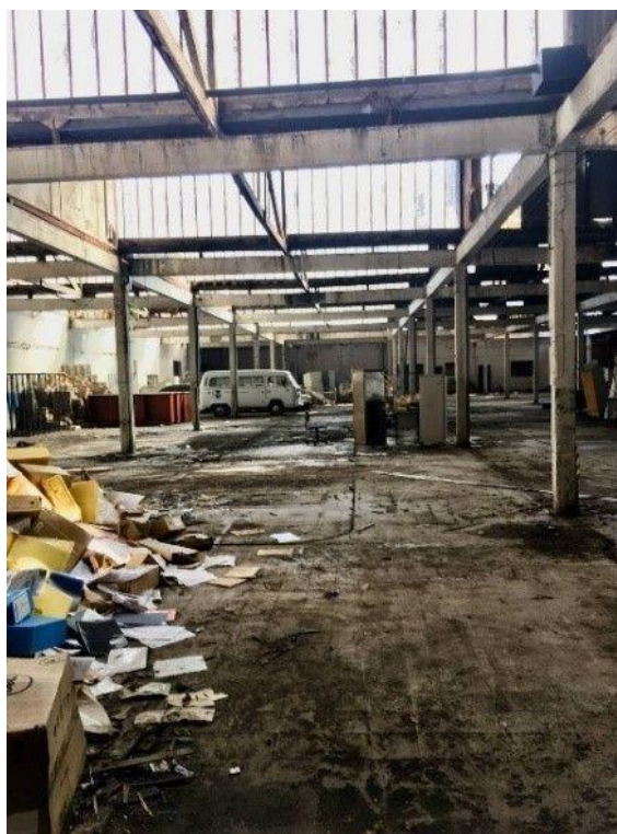
Figura 21 - Vista da parte interna da Quadra D
