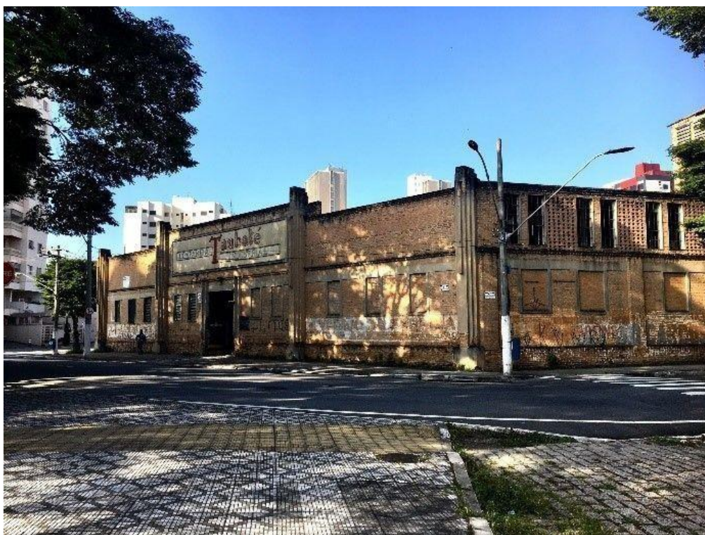
Figura 19 - Fachada da Quadra D
