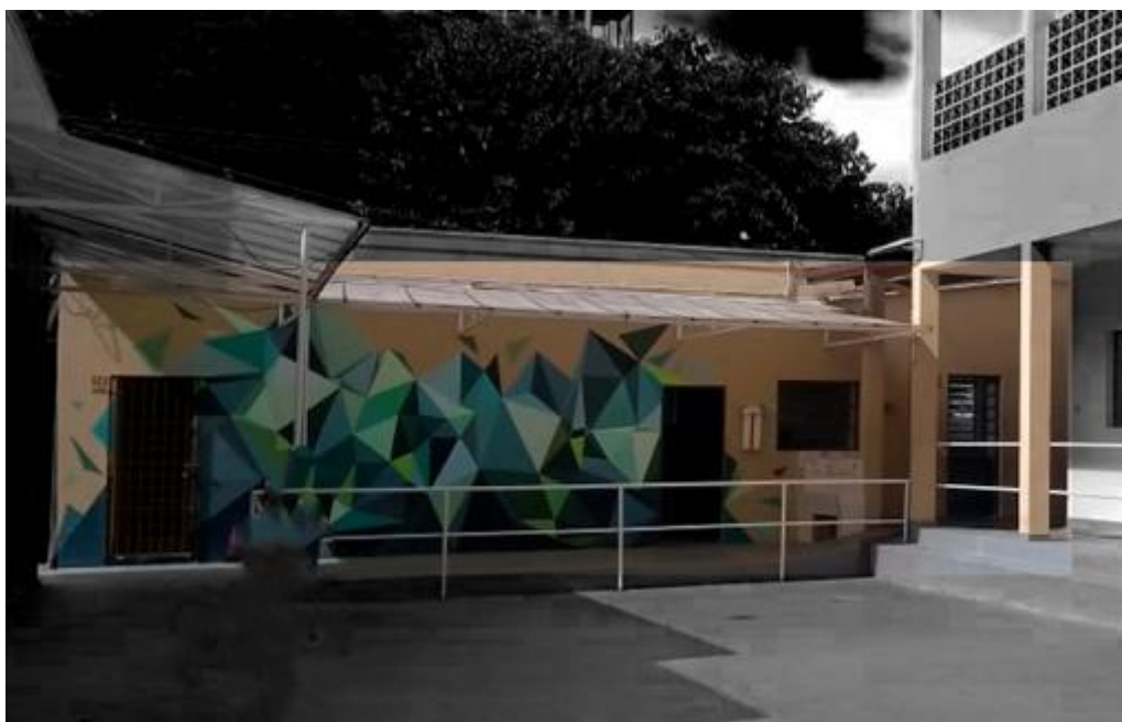
Figura 27 - Escola Maestro Fêgo Camargo situação 03
