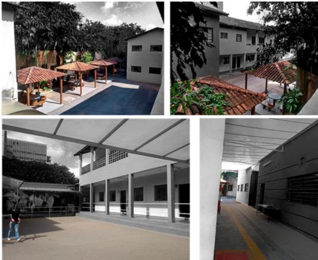
Figura 28 - Escola Maestro Fêgo Camargo situação 04
