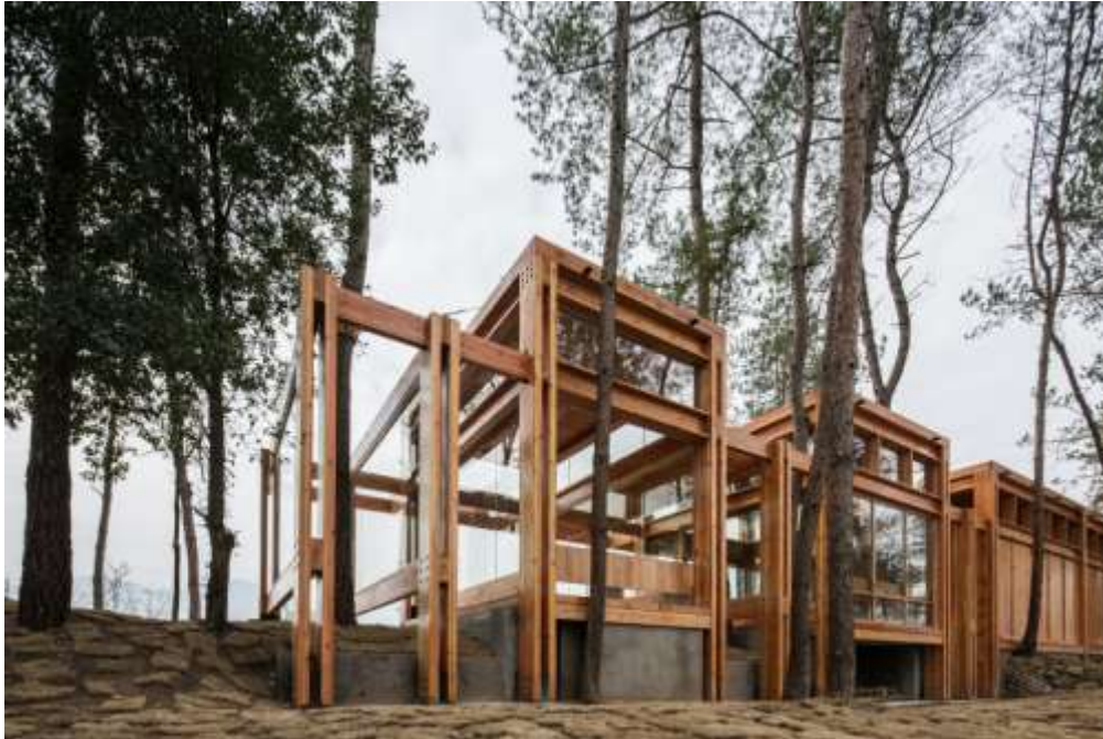
Figura 26 Pavilhão do Pinho
