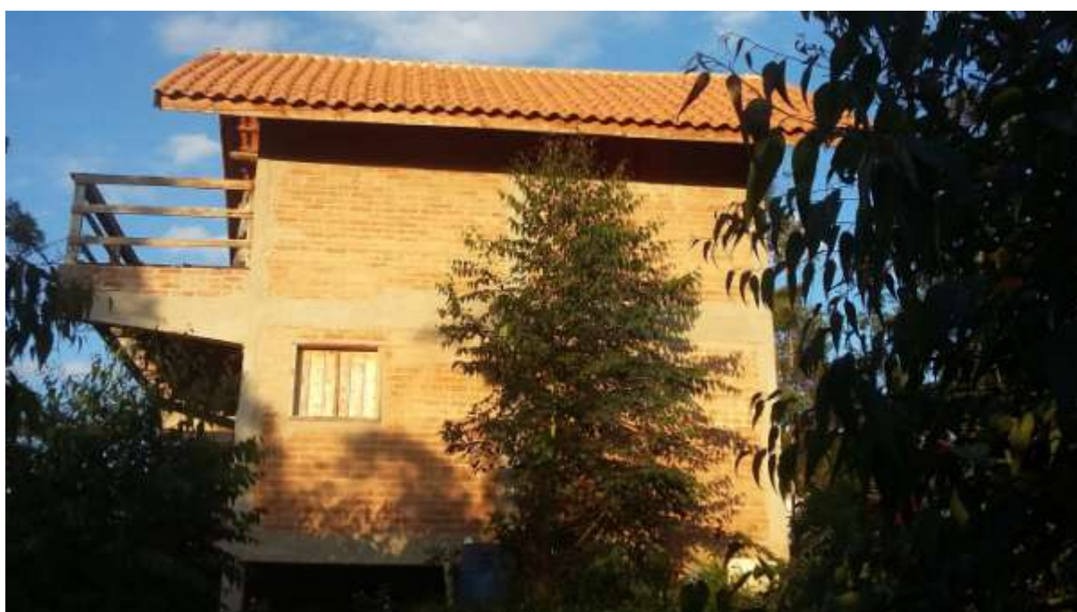
Figura 43 Construção existente encontrada no local
