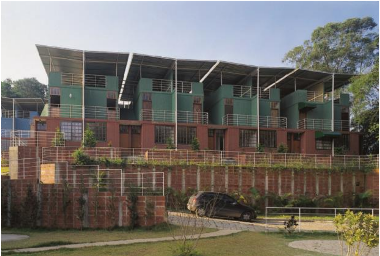
Figura 1. Fachada Residencial cotia.
