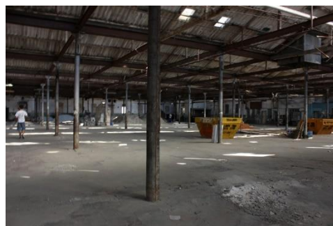
Figura 10: Quadra D – Galpão com caçambas
