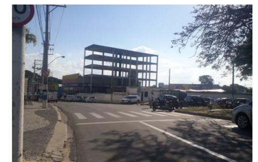
Prédio abandonado Acervo da autora, 2019.
