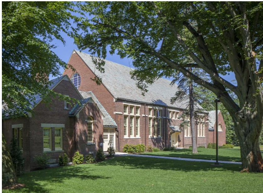
Figura 2. Fachada do Centro de Autismo e Cérebro em Desenvolvimento Fonte: E4harchitecture, 2018
