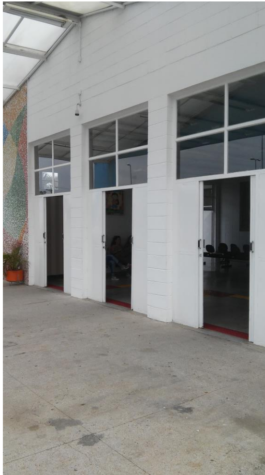
Figura 33. Entrada recepção Fonte: Autora
