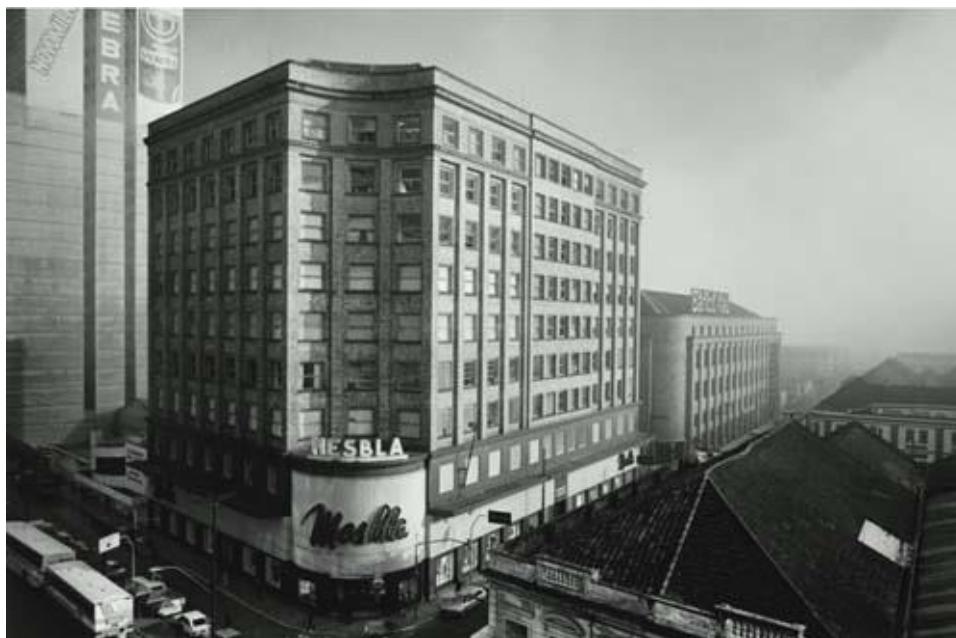
Figura 8 – Antigo prédio do Mesbla, na rua 24 de maio, São Paulo.
