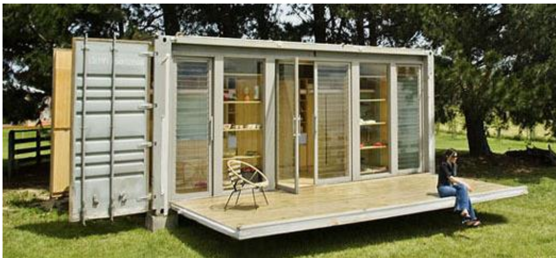
Figura 6- Container como abrigo modular
