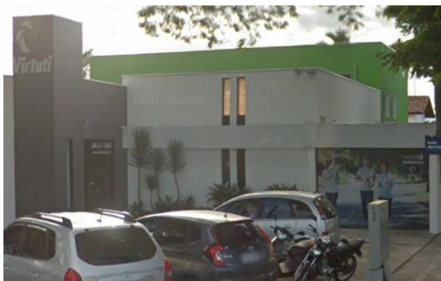
Figura 57 - Entrada secundária da clínica.
