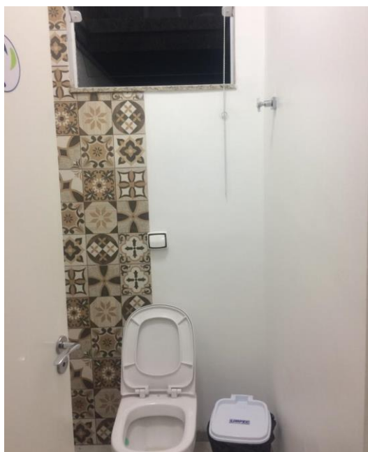
Figura 59 - Sanitário feminino da recepção.
