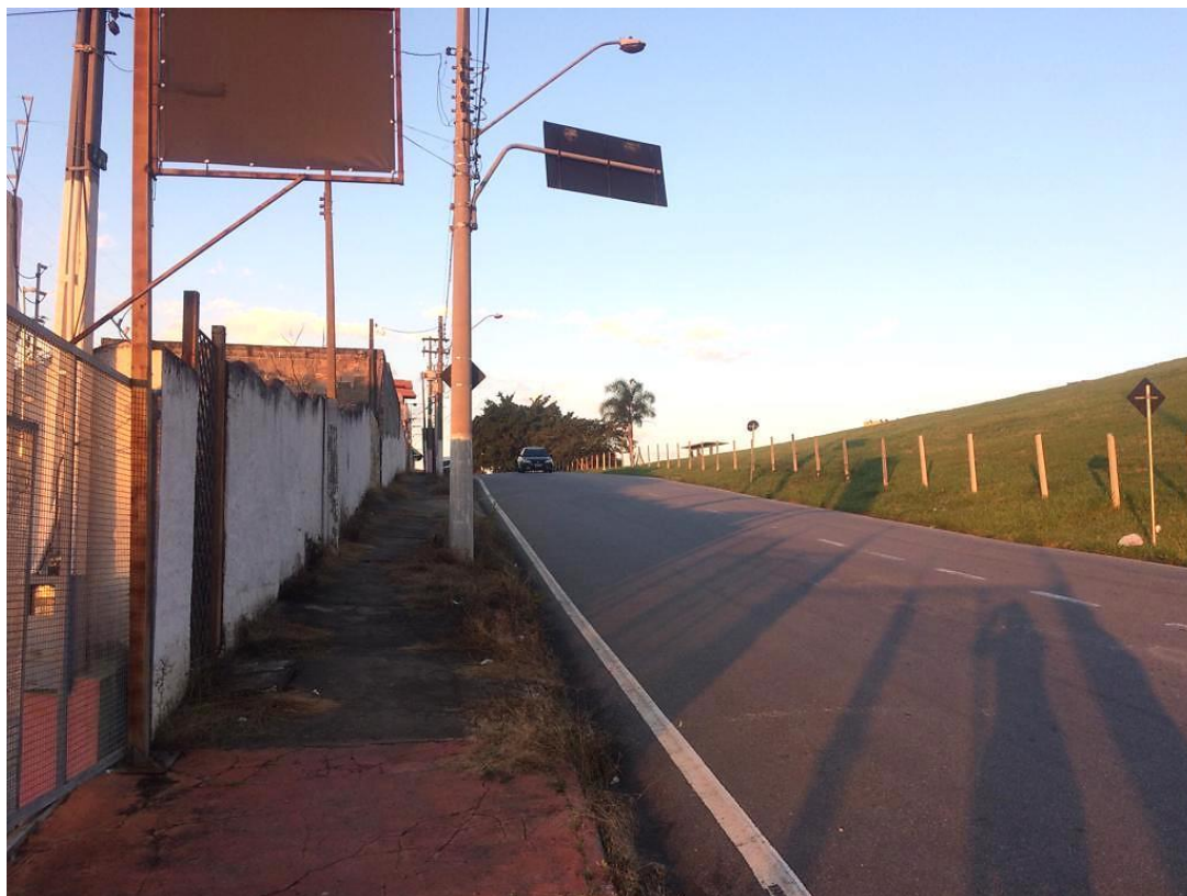
Figura 83 - Vista rua lateral do terreno – Avenida Bandeirantes.
