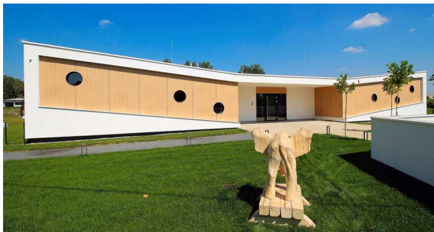
Figura 24 - Fachada do Jardim de Infância
