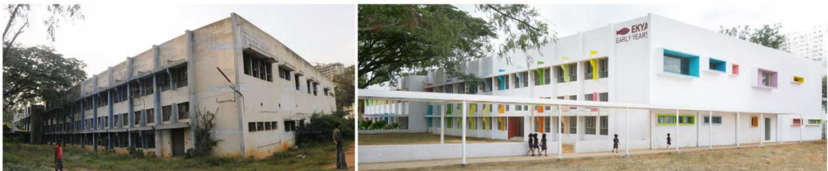
Figura 18 - Antes e depois do edifício escolar
