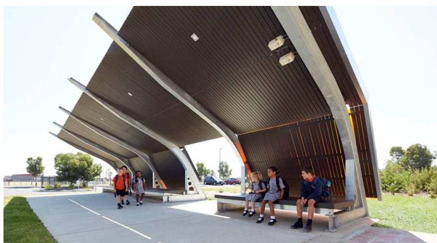
Figura 15 - Bancos para aulas protegidas por beirais
