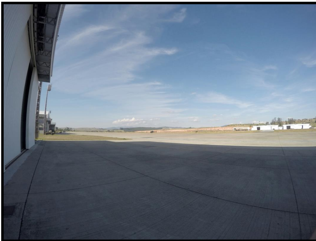
Figura 21. Pista de pouso e decolagem.
