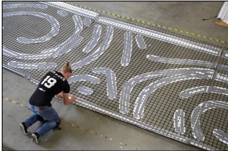
Figura 11: Instalação LEDS na Ciclovia Van Gogh
