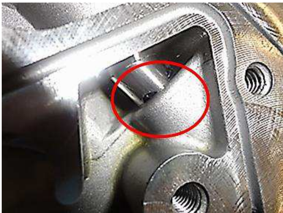
Figura 12 – Bomba de óleo com válvula de retorno travada.
