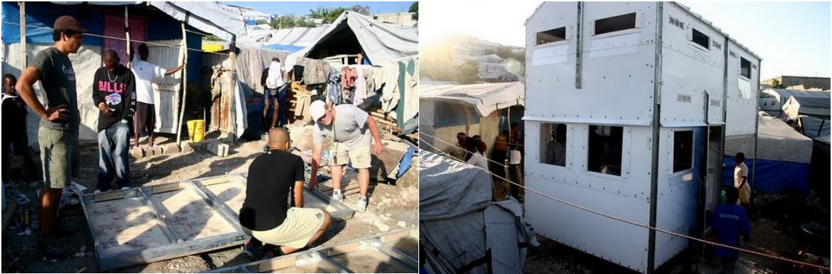
Figura 5- Montagem Uber Shelter
