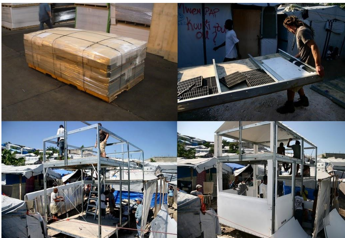
Figura 4- transporte e montagem do Uber Shelter
