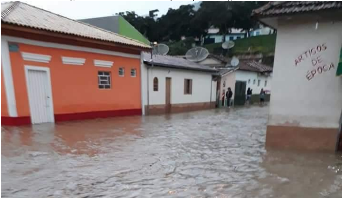
Figura 21- Ruas da vila de Catuçaba repletas de água
