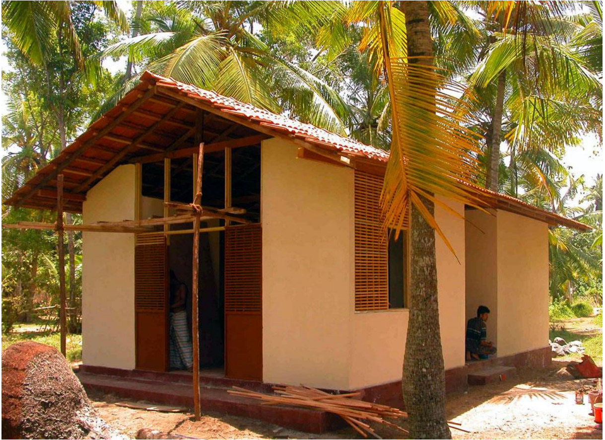
. Fonte: Design Emergencial
