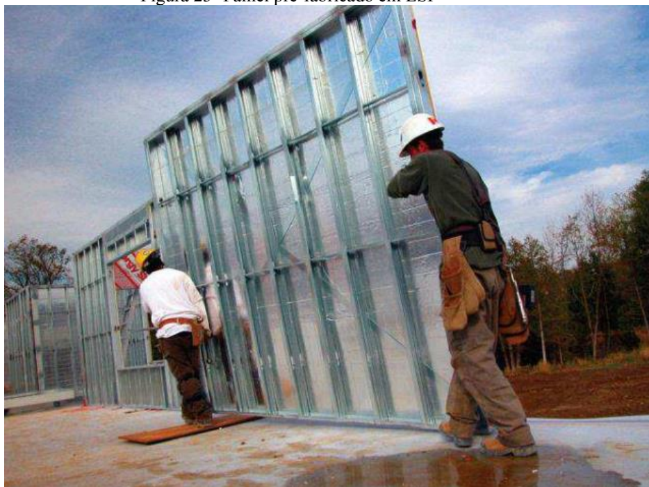
Figura 23- Painel pré-fabricado em LSF
