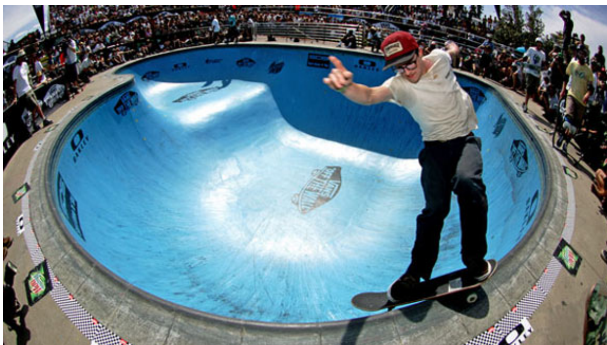
Figura 11 - “Bowl” feito de concreto com bordas “coping-block”.
