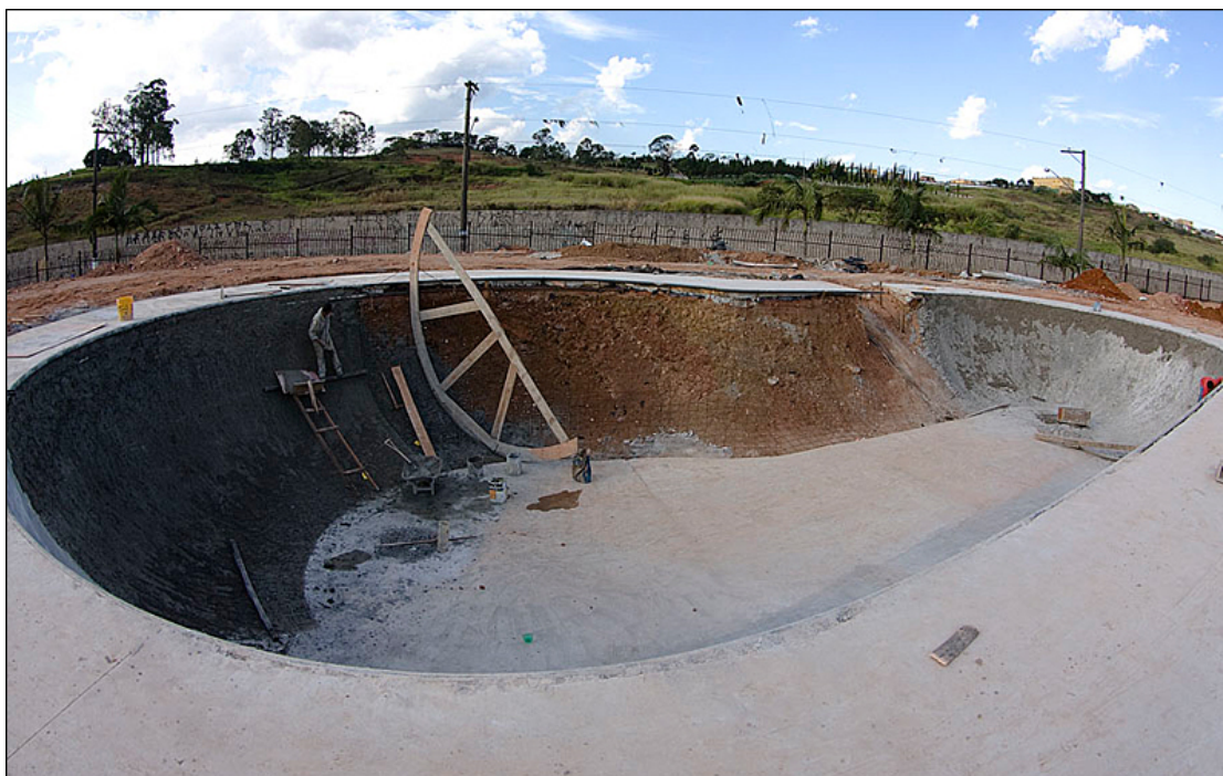
Figura 13 - Construção de um “Bowl” em Santo André
