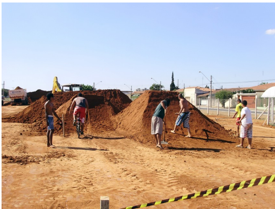
Figura 14 - Construção de um “DIRT”.
