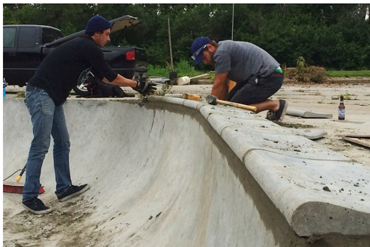
Figura 16 - Pista de concreto com “coping-block”
