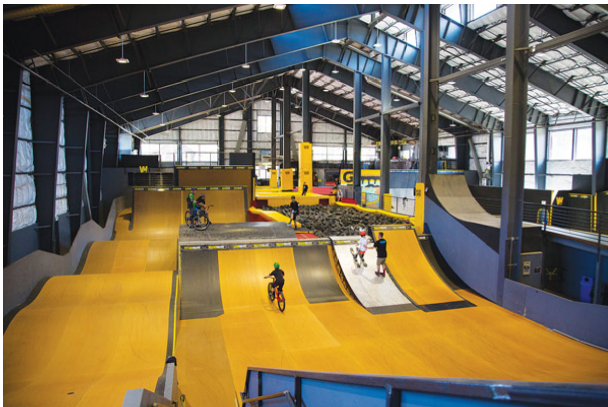
Figura 33 - Galpão que compõe parte da estrutura do WoodWard Tahoe.
