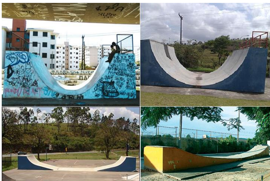
Figura 17 - Rampas com transições e “flats” completamente errados.
