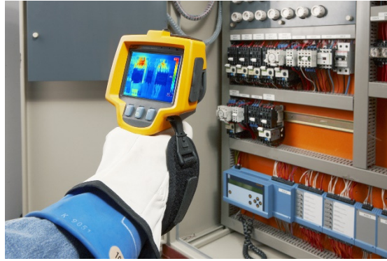
Figura 1 - Aplicação do uso de termografia.
